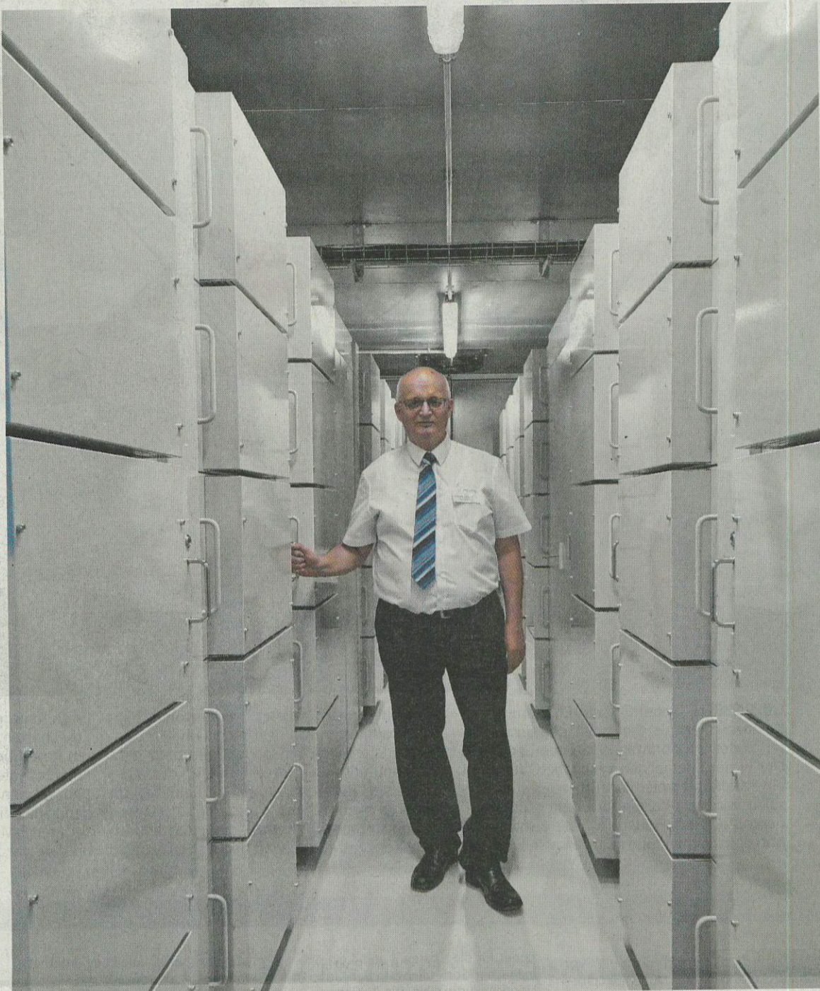
Wilhelm Pfenning im Innern des Containers, in dem Hunderte von Lithium-Eisenphosphat-Akkus 2500 Kilowattstunden Energie speichern. FOTOS: GERHARD MEISSNER
