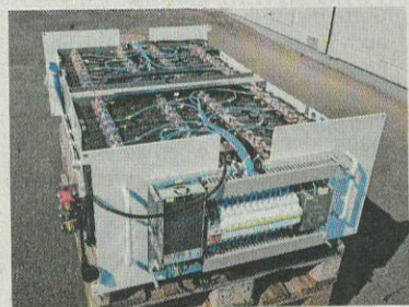
Aus vielen solcher Module mit Lithium-Eisenphosphat-Zellen ist der 2500-kWh-Energiespeicher aufgebaut.
